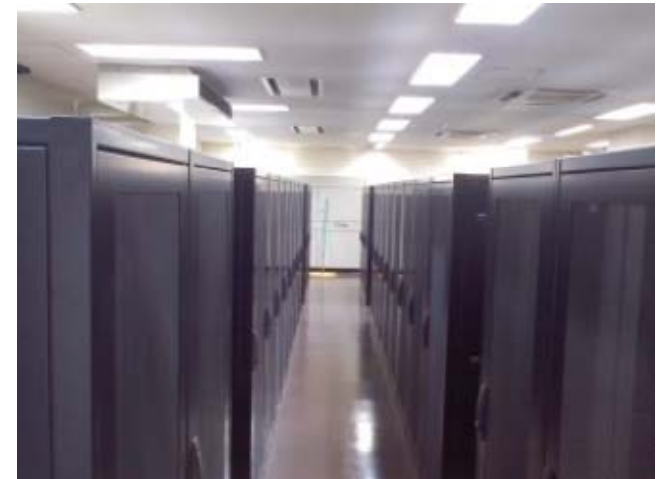
【増床が完了したデータセンター設備】
